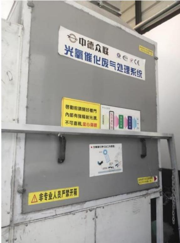
喷烤漆房废气处理装置
